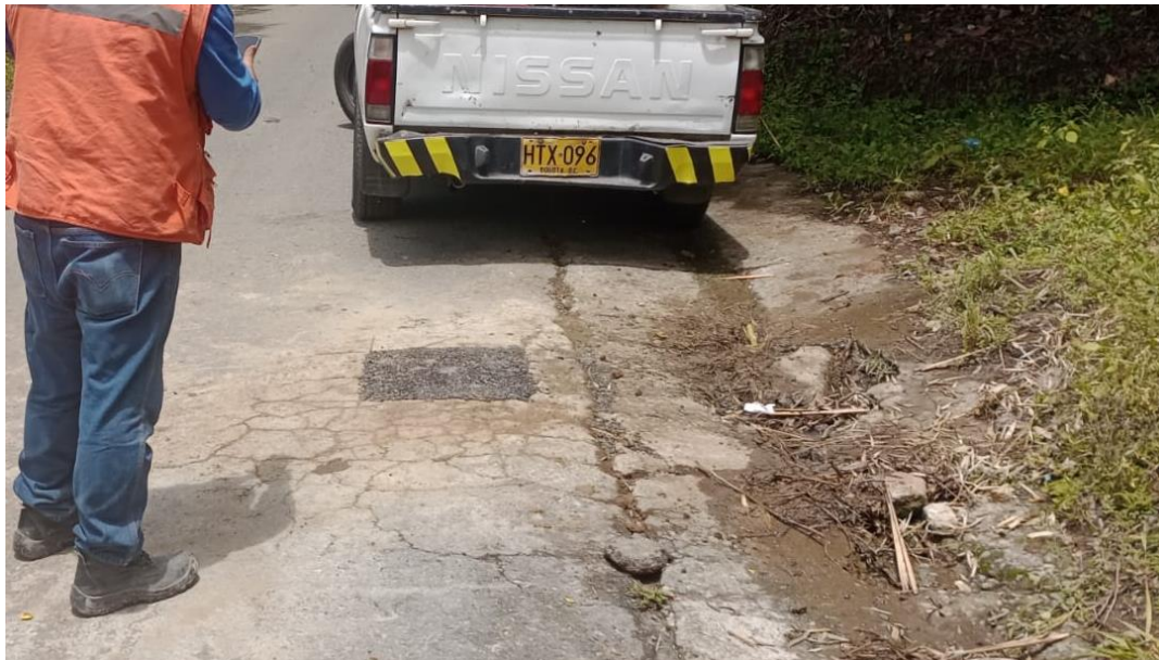
Fotografía 8. Relleno y compactación de la calicata No. 1 Fuente: Tomado en terreno.
