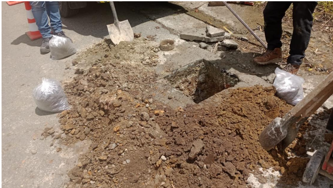
Fotografía 7. Excavación de la calicata No. 1
