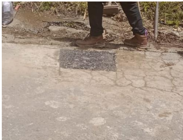
Fotografía 3. Relleno y compactación de calicatas
