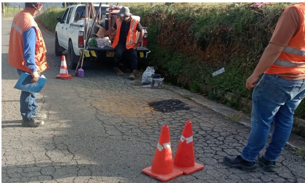
Fotografía 14. Relleno y compactación de la calicata No. 3 Fuente: Tomado en terreno.
