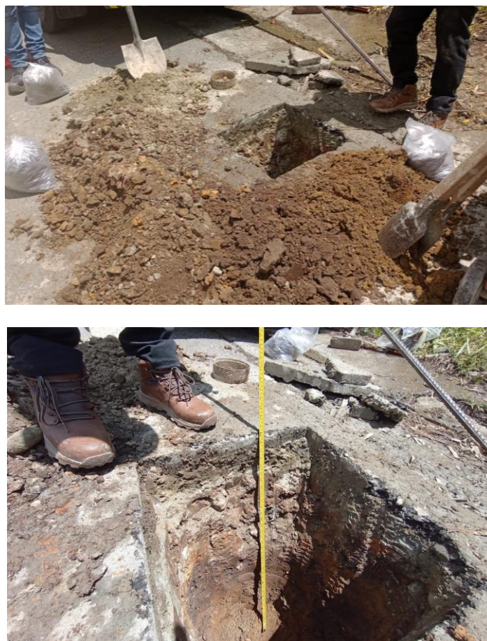
Fotografía 1. Excavación de la calicata
