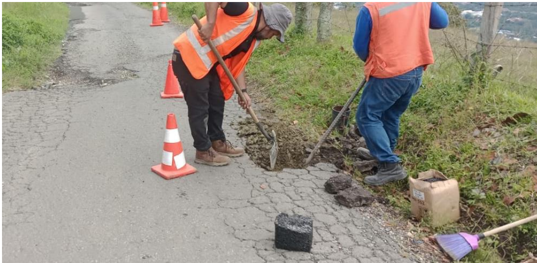
Fotografía 10. Excavación de la calicata No. 2
