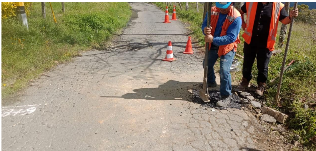
Fotografía 11. Relleno y compactación de la calicata No. 2
